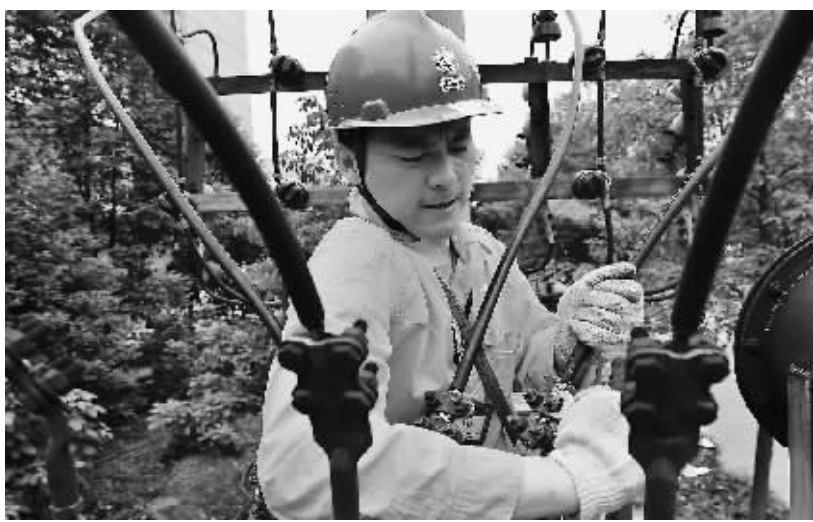
成都供电公司员工在线路迁改现场工作。 邓超 摄
